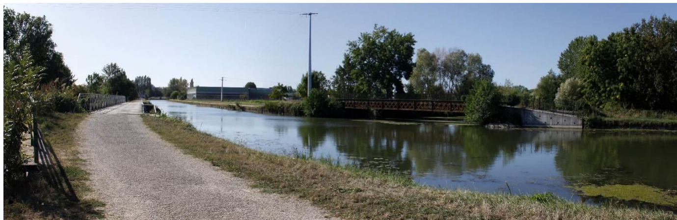
Illustration 22 : la voie verte du canal du Loing à Chalette-sur-Loing (tronçon de l'EuroVelo3)
