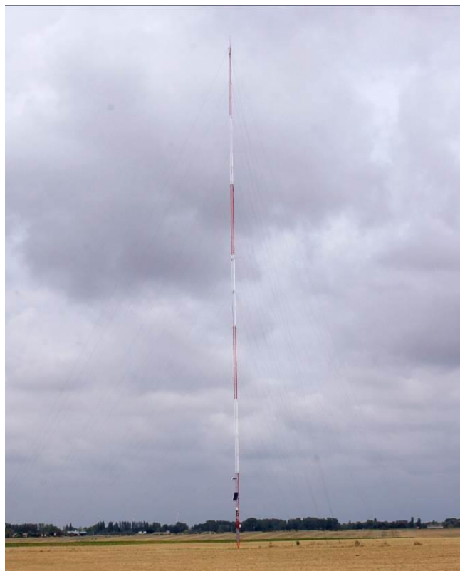
Illustration 33 : le mât de mesure de vent dans la ZIP nord
